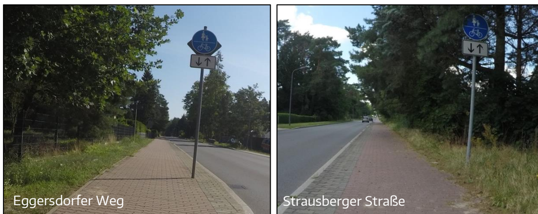
Abb. 4 Bestandssituation einseitige Beidrichtungsgeh- und Radwege
