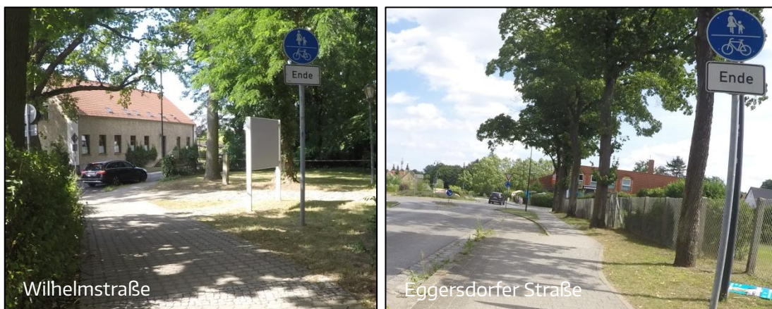
Abb. 6 Bestandssituation Anschlussbereiche bestehender Radverkehrsanlagen
