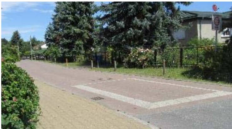
Foto: Reduzierung der gefahrenen Geschwindigkeit durch Aufpflasterungen: hier in der Mittelstraße (Petershagen)
