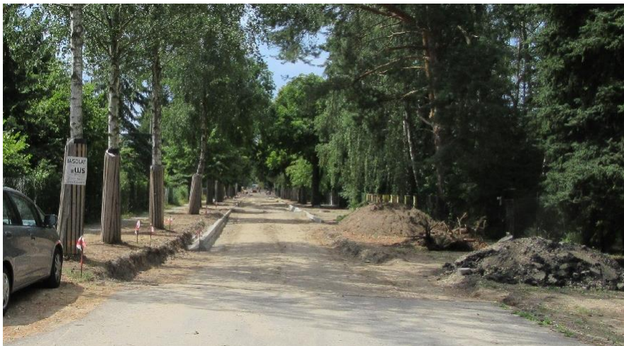
Foto: Grundhafte Straßensanierung in der Schillerstraße (Stand: Juli 2016)
