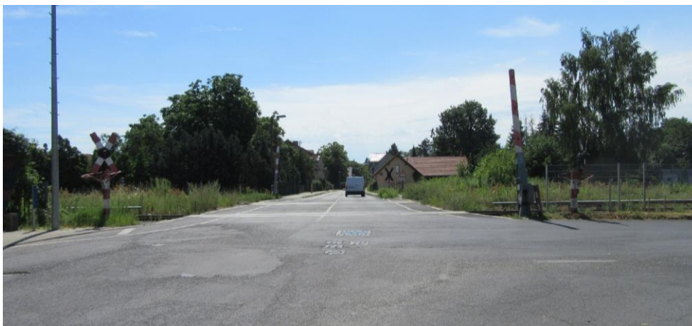
Foto: Beispiel Knotenpunkt Bahnhofstraße (von rechts)/ Bruchmühler Straße (im Rücken) und Lindenstraße (geradeaus über BÜ): breite Fahrbahnen, Fußgängerbereich z.T. nur abmarkiert, Sichtbeziehungen sind nur unzureichend gegeben
