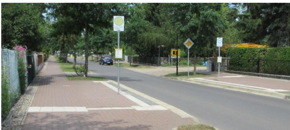
Foto: Beispiel für Haltestellen in Petershagen/ Eggersdorf: spaltarmes Einsteigen dank Buskapstein, taktile Kennzeichnung/ Blindenleitstreifen, kontrastreiche Materialität der Bordkante, gut nutzbare Zuwegung (hier: Haltestelle Lessingstraße)
