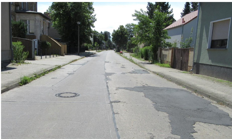
Foto: Verschlossene Betonfahrbahn in der Lindenstraße
