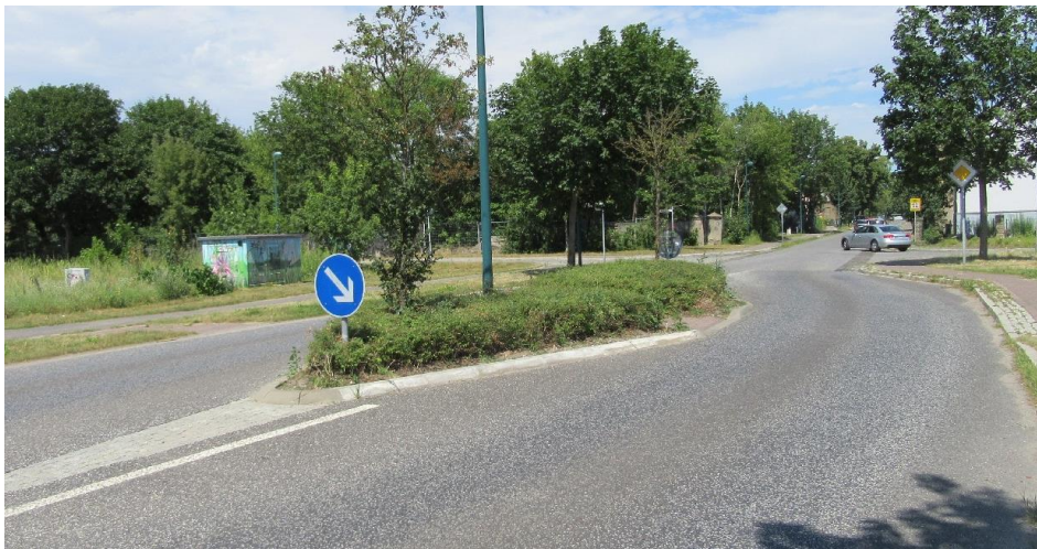
Foto: Mittelinsel zur Verdeutlichung der Ortseingangssituation, hier auf der L 30 südlich der Wilhelm-Pieck-Straße
