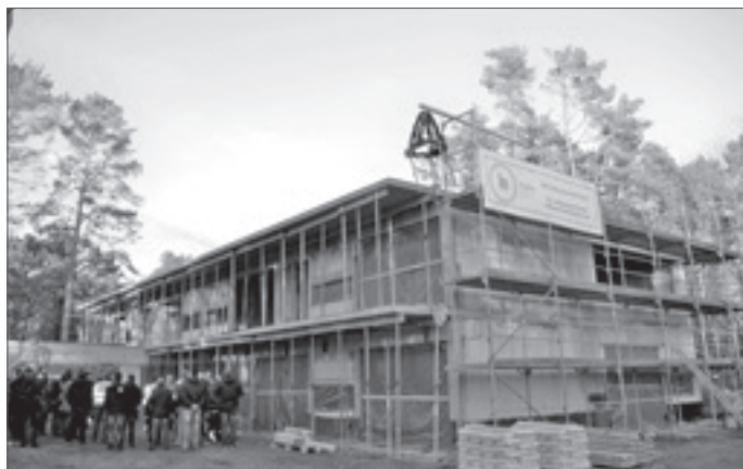
• Am 18. Dezember wurde im Beisein von zahlreichen Gemeindevertretern Richtfest für die neue Kita des IB gefeiert.
