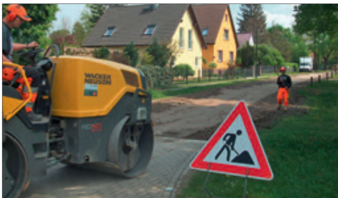
• Wenn alles passt, wird geglättet: Bauhofmitarbeiter in der unbefestigten Karlstraße. Foto: K. Brandau
