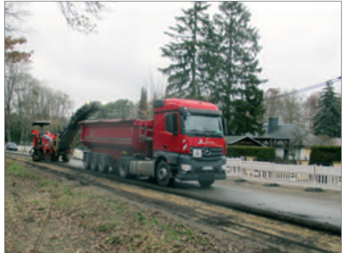
● Der alte Asphalt wird abgefräst auf der Altlandsberger Chaussee in Höhe der Restaurants Foto: R. Dommitzsch
