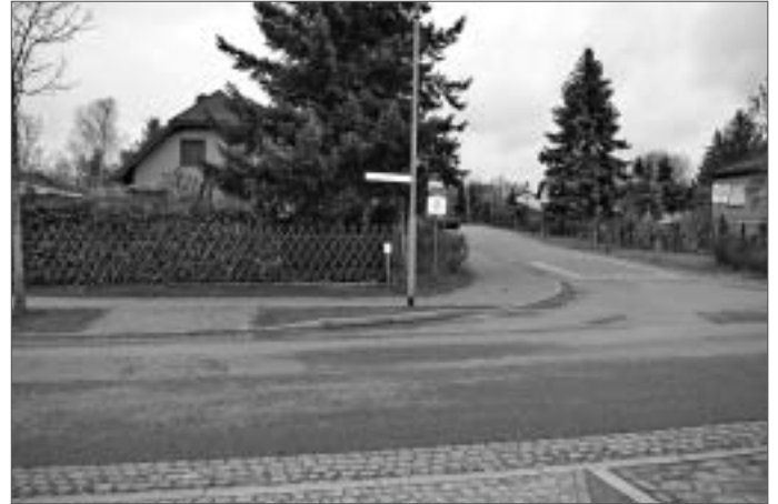
• Die neue Querung in der Wilhelm-Pieck-Straße.
