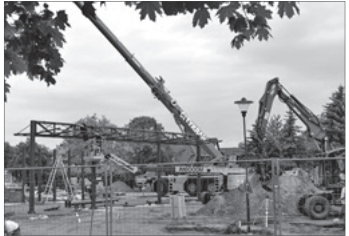
● Mit Hilfe großer Krantechnik wird der Haltestellenplatz für die Busse montiert.
