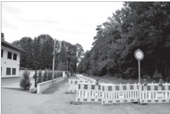
● Im Juni wurde mit dem 5. Bauabschnitt begonnen vom Stillen Grund bis zum Hotel Villago.
