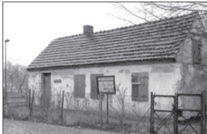
● Lang ist's her: Das Buednerhaus vor der Sanierung im Jahr 2004.
