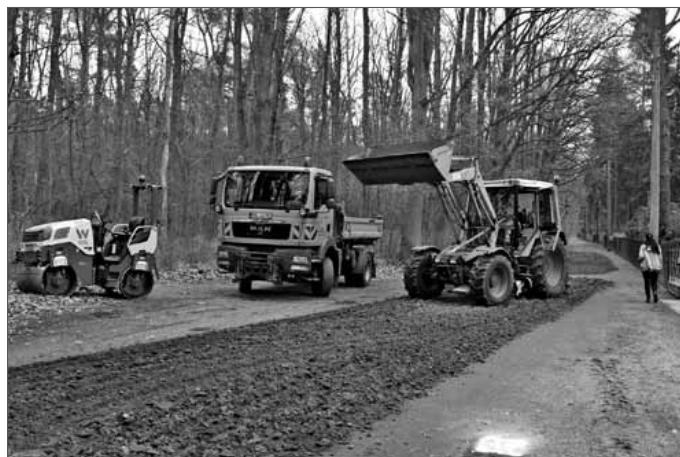
● Im Frühjahr wurde der unbefestigte Teil der Grenzstraße in Eggersdorf durch den Bauhof planiert. Foto: K. Brandau
