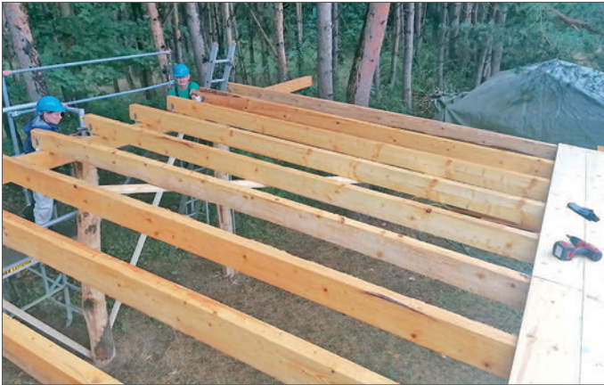
• Nabu-Aktive legen beim Dachbau fleißig Hand an
