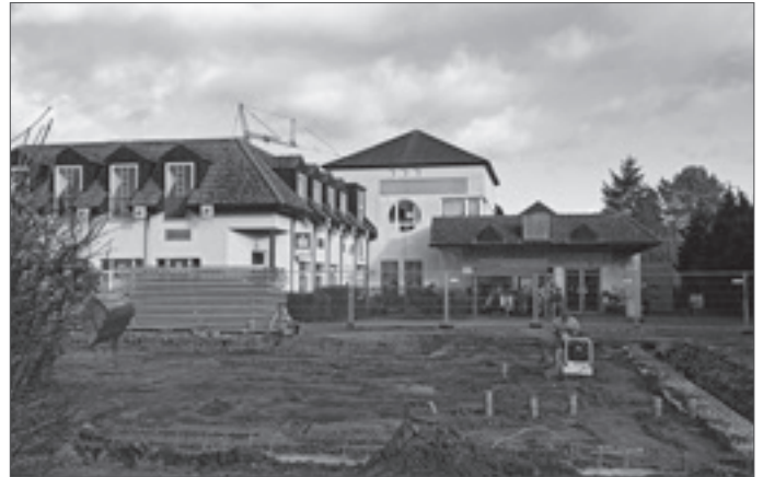
• Noch am 04. Februar dieses Jahres war an der Stelle des Neubaus der alte Parkplatz geplant und eine Baugrube wurde vorbereitet. Nur sechs Monate später steht die neue Sparkassenfiliale. Am Ort der alten entsteht nun ein neuer Parkplatz.
