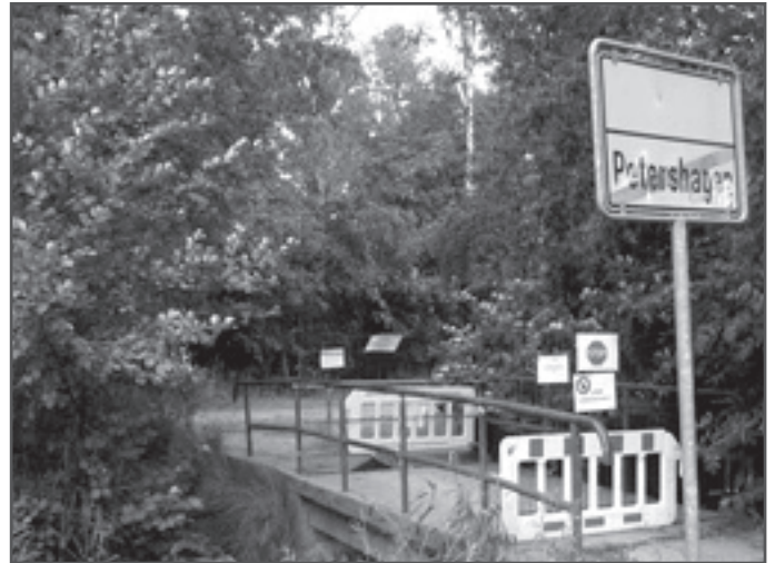
● Gesperrt und nicht mehr passierbar: Brücke über das Fließ in Nähe der Andreas-Hofer-Straße Foto: L. Jendreizik
