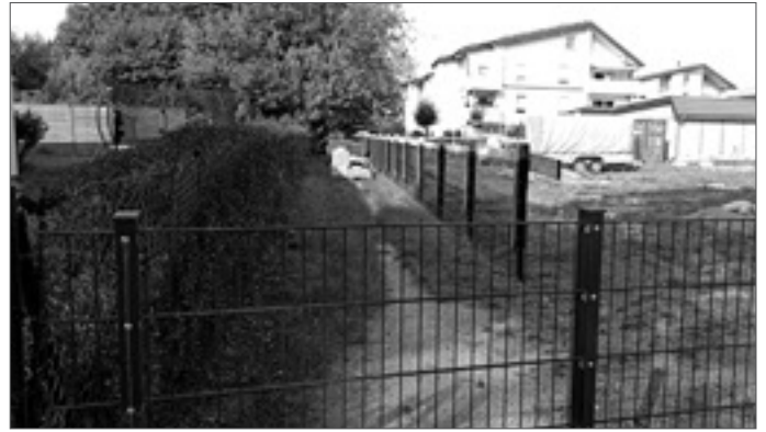
• Kein Durchgang: Momentan ist der Weg zwischen Clara-Zetkin- und Elbestraße gesperrt. Foto: K. Brandau
