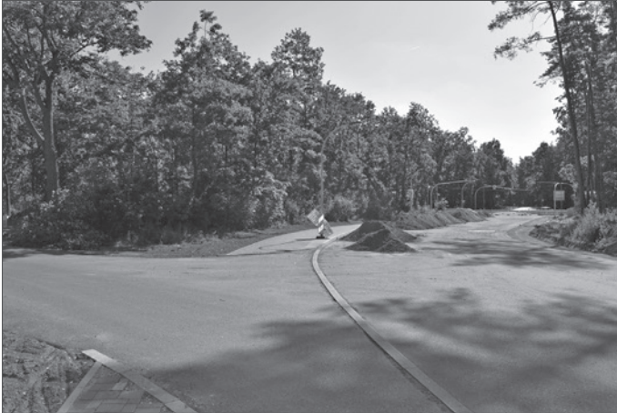
● Die Chaussee, Blickrichtung Strausberg. Der Abzweig links soll noch abgerissen werden. Foto: K. Brandau
