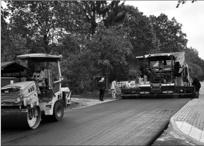
● Asphalt für die Rückertstraße.
