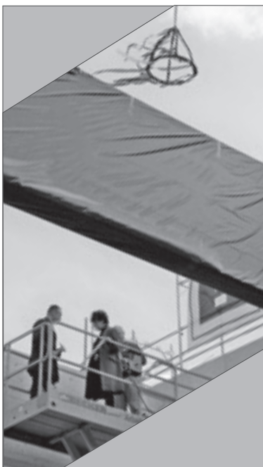
● Per Hebebühne ging's zum traditionellen Nägelschlagen in luftiger Höhe auf den Dachbalken mit Bürgermeister, der Fachbereichsleiterin Bauen sowie dem Zimmermann (v.li.)
