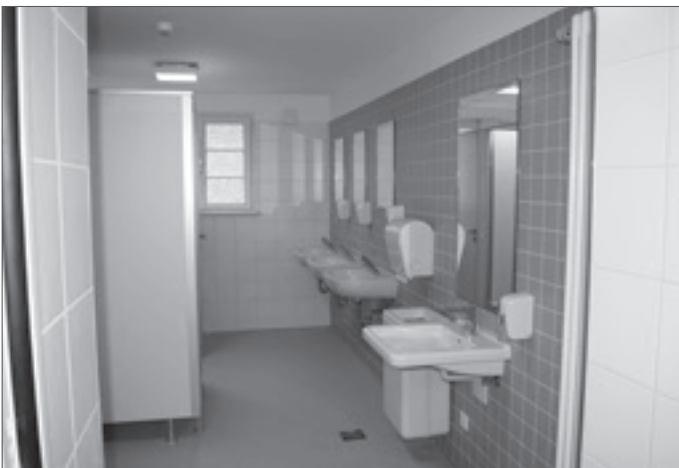
● Auch der Sanitärbereich wurde saniert und umgestaltet.
